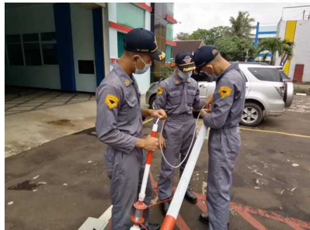
Gambar 5. Pemasangan kabel portable windsock
