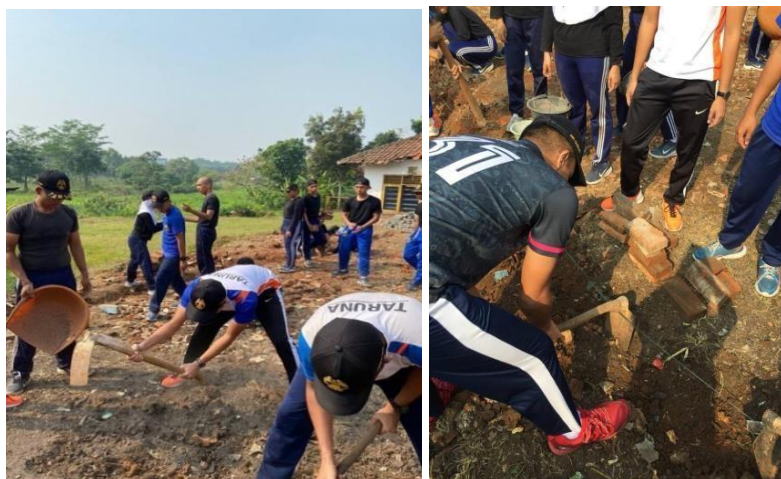
Gambar 2. Pembersihan Lokasi Pemasangan Paving block
