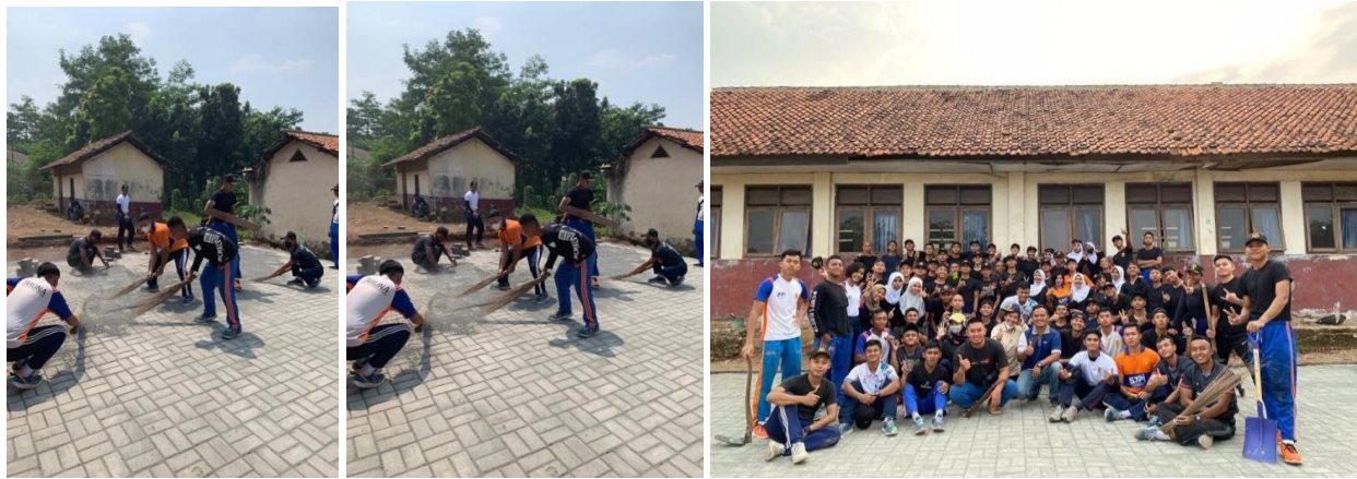
Gambar 3. Kegiatan Pemasangan Paving block dan Penghamparan Abu Batu
